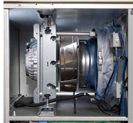
Nowoczesna konstrukcja wentylatora o nazwie Wing+
